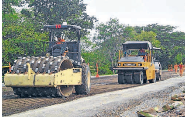
La ANI dejó claro que la obra del tercer carril en la vía Bogotá-Girardot no se ha adjudicado y se pueden presentar propuestas.
