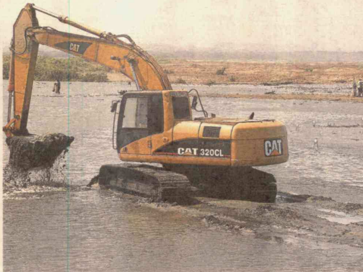
La firma ejecutaría obras de encauzamiento, mantenimiento y dragado en el río. Archivo
