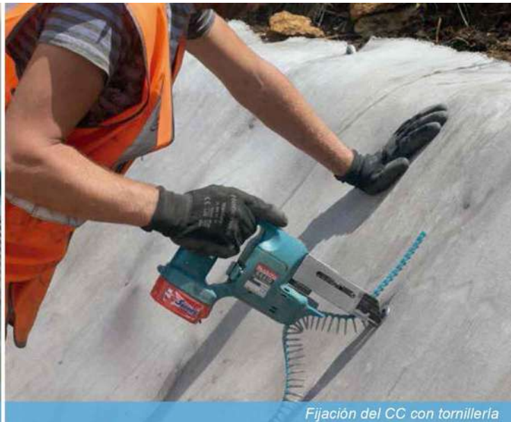
Fijación del CC con tornillería
